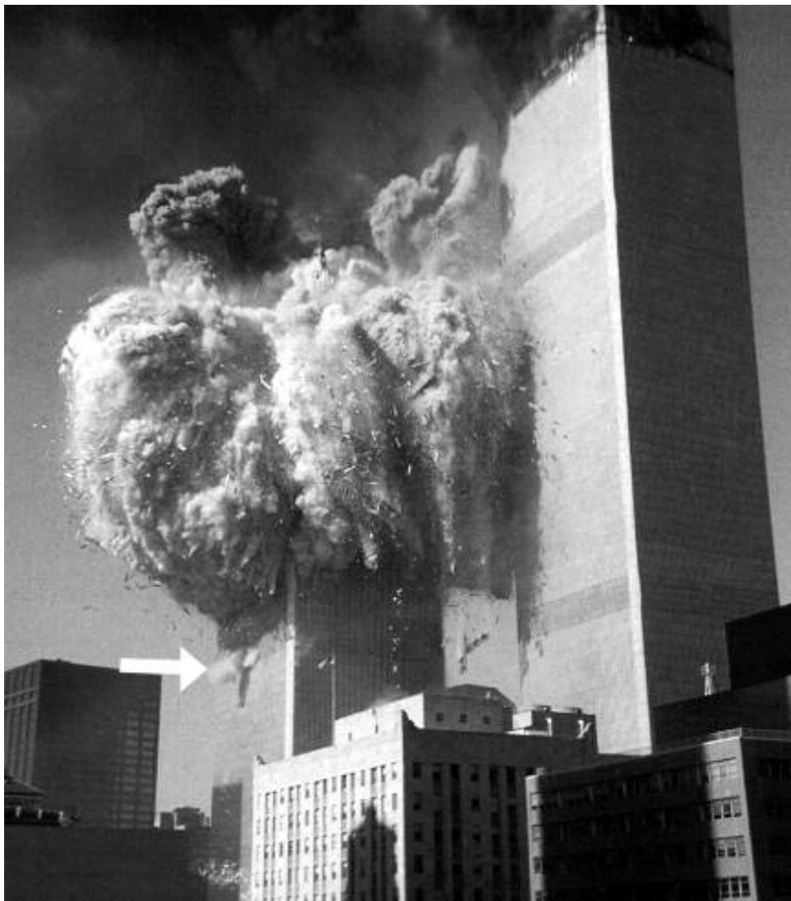
Der Pfeil zeigt eine der Explosionen in den Stockwerken unterhalb der Zone des Zusammensturzes, die offenlegen, dass es sich um eine kontrollierte Sprengung handelt.
